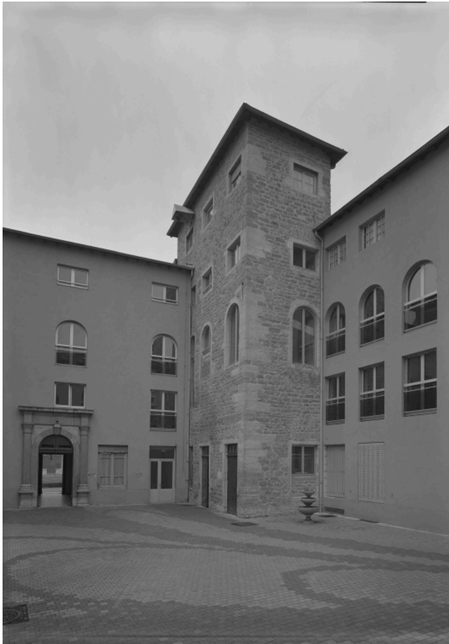
Cour intérieure : tour dans l'angle nord-ouest.
