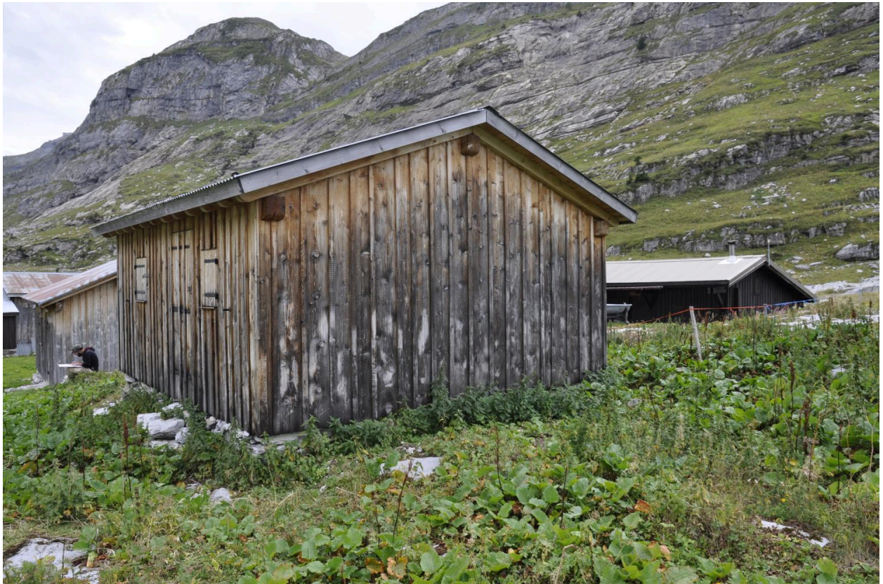
Vue du mur pignon nord
