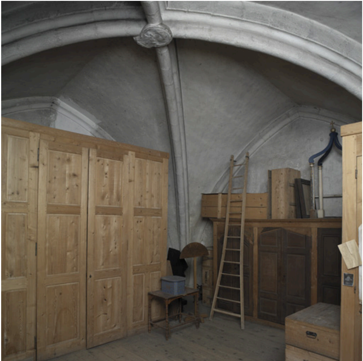
Vue générale de l'étage situé au-dessus de la sacristie annexe 1 (travée I, collatéral sud).
