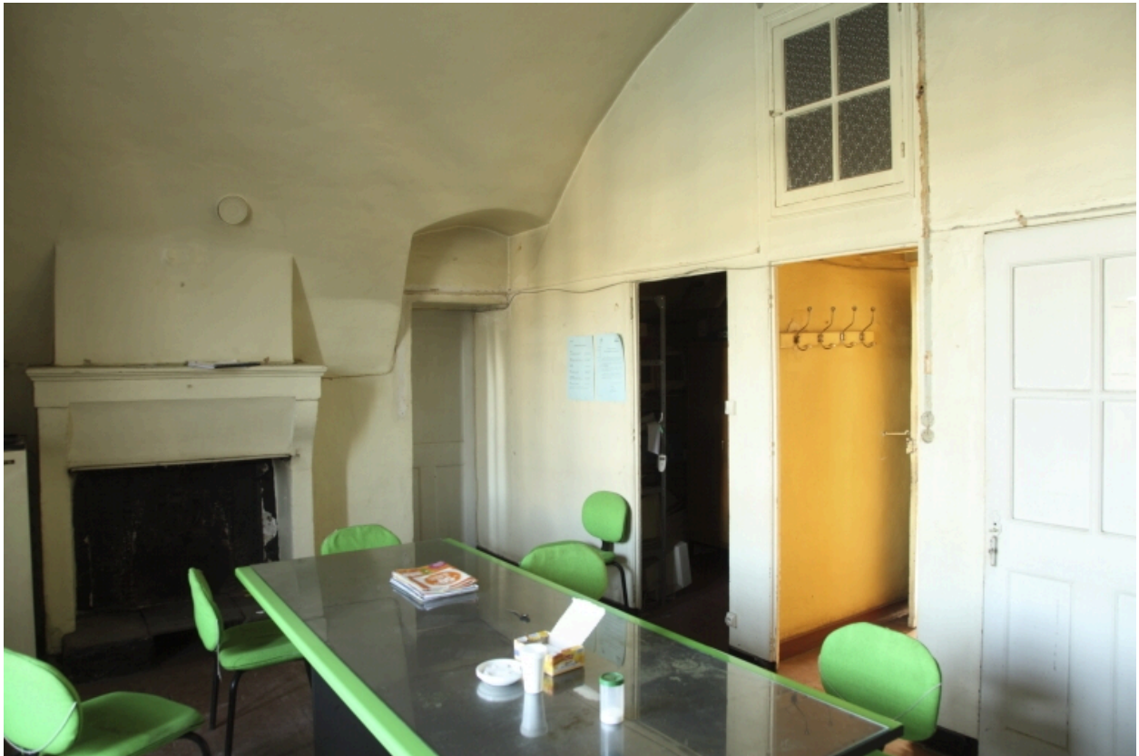
Bâtiment A, 1er étage. Greta. Cuisines.
