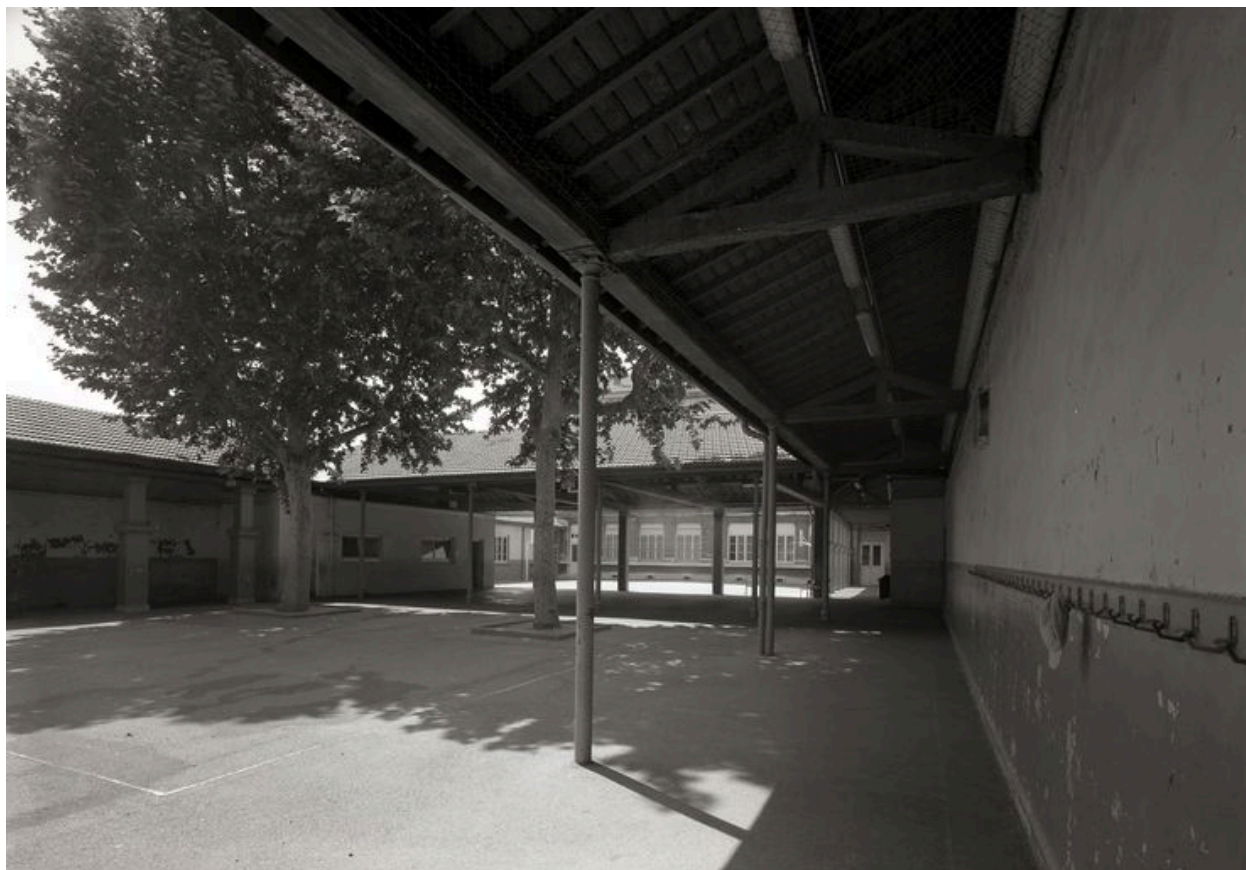
Cour centrale. Vue d'ensemble depuis le nord-ouest
