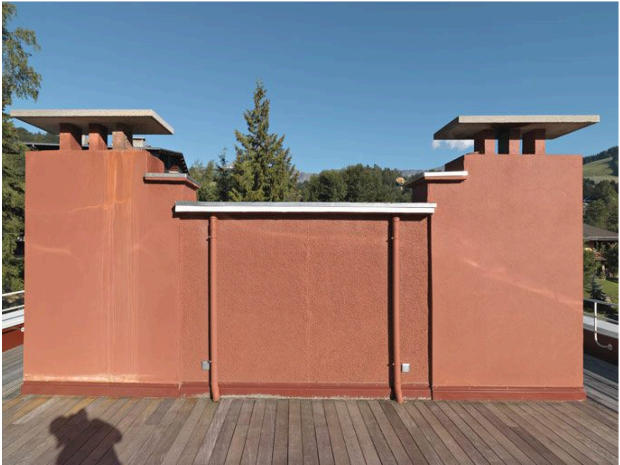
Le roof sur le toit terrasse
