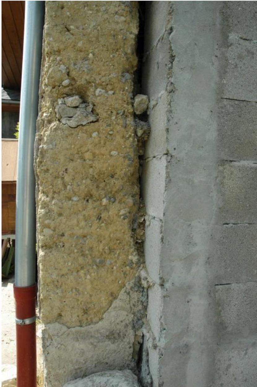
Ferme (dénaturée) Chez le Bret (2016 A8 668), non repérée ; détail de mur en pisé à l'angle d'une ancienne grange.
