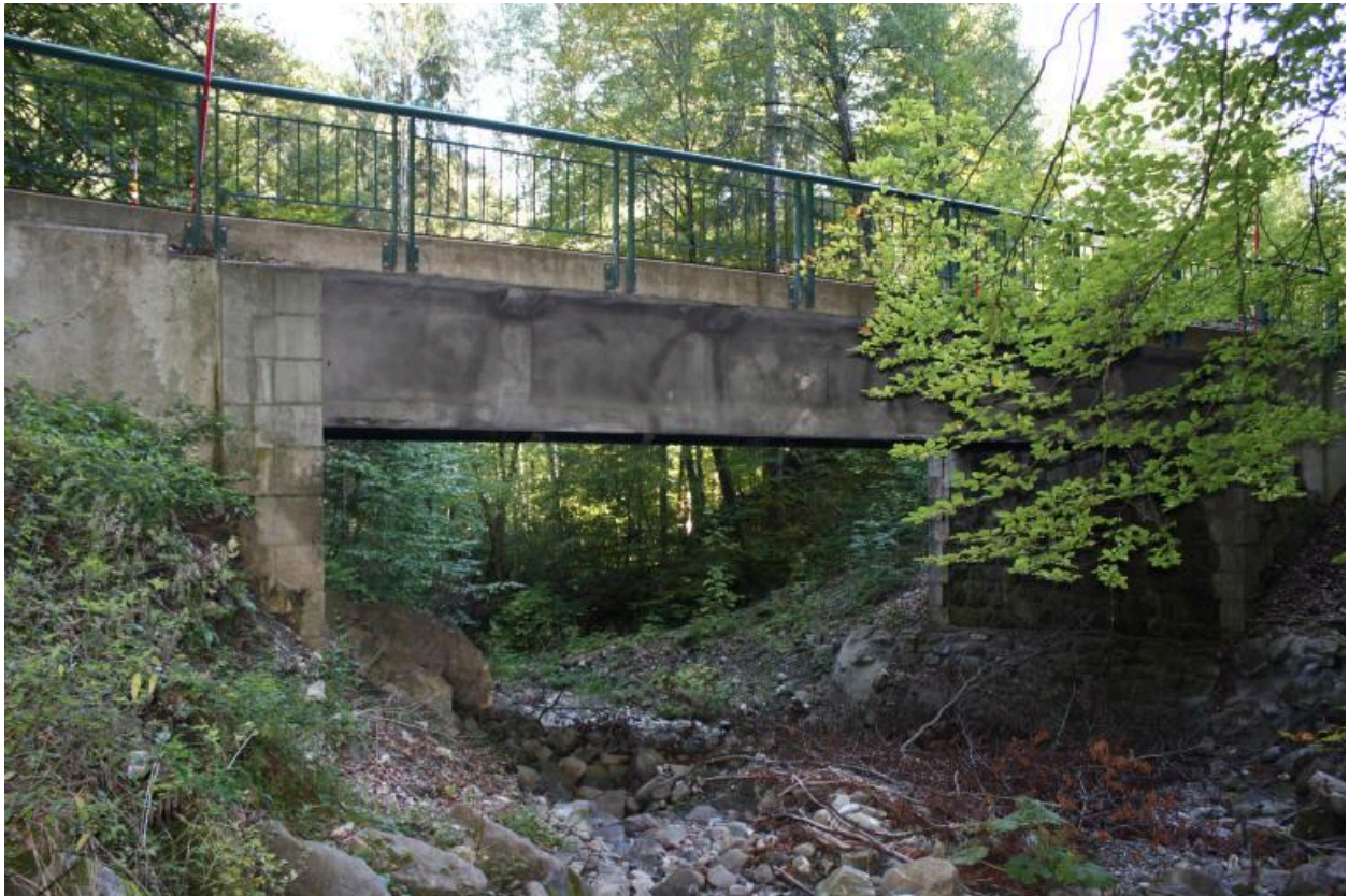
Le pont de la route de Montriond, face amont
