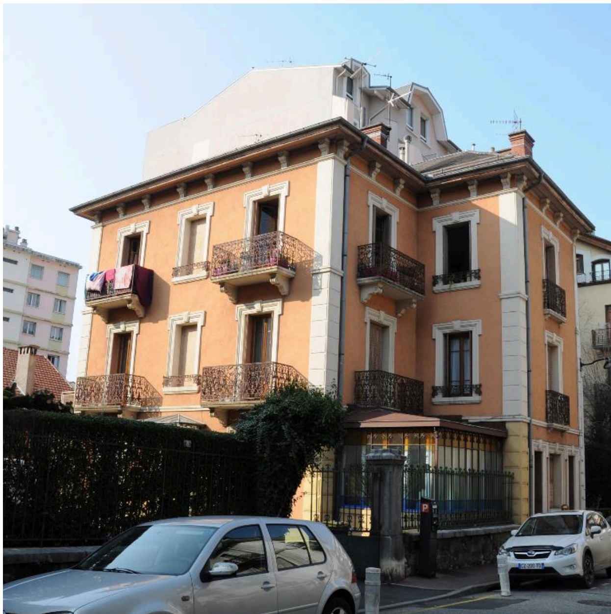
Vue d'ensemble depuis la rue
