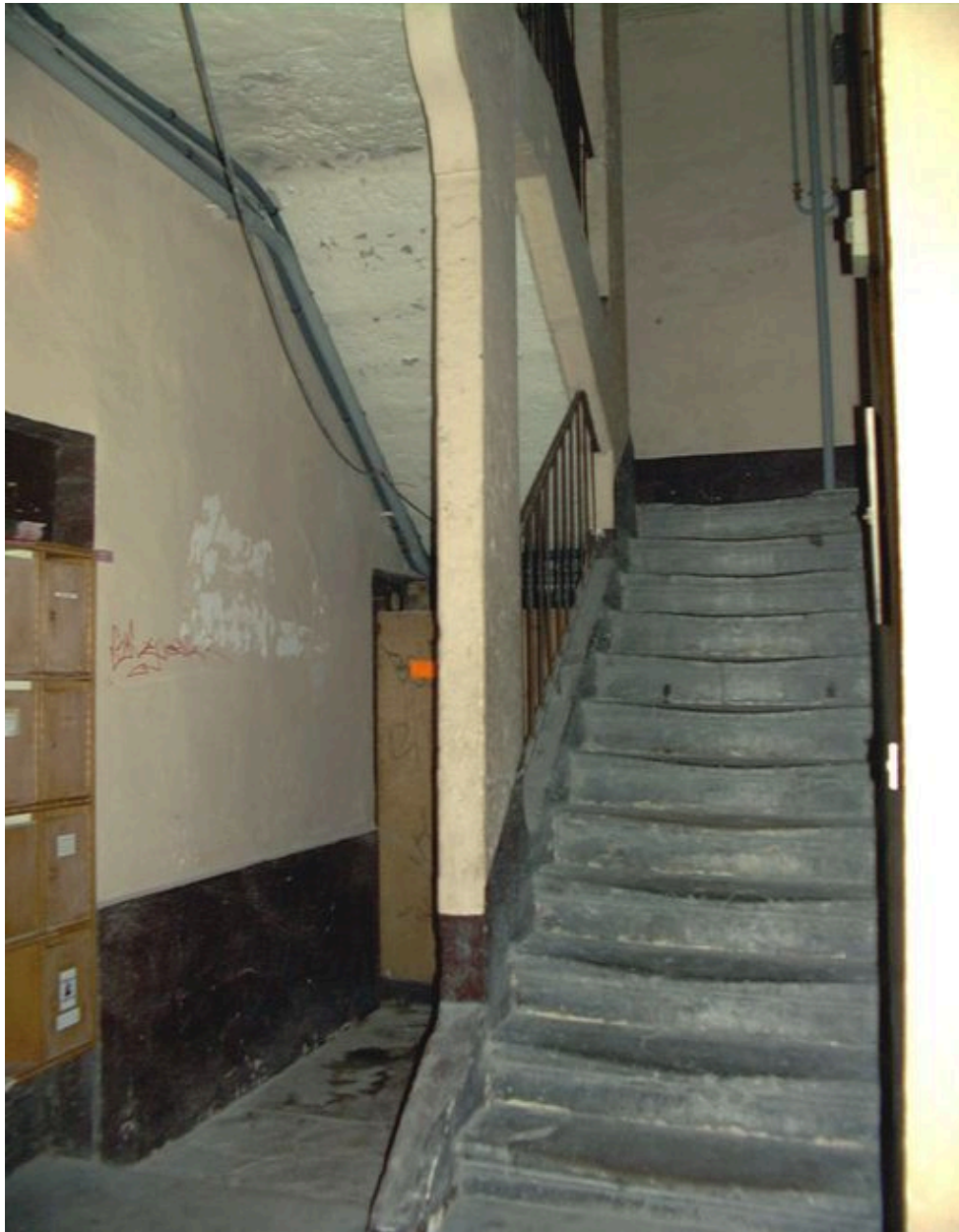
Vue de l'escalier commun aux 10 rue Ferrachat et 7 rue Bellière
