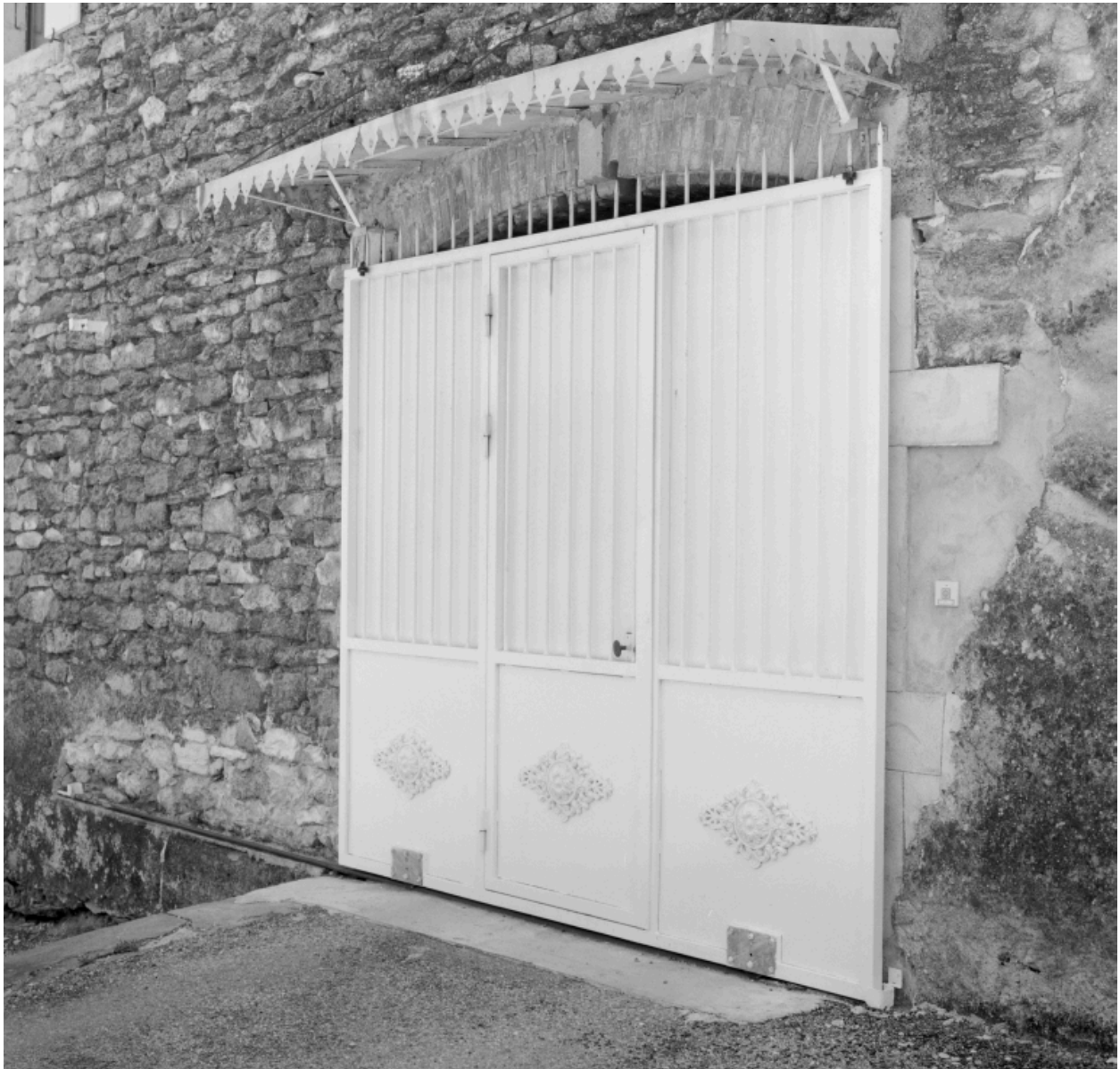
Détail de l'auvent en zinc à décor de feston de la ferme (A2 707).
