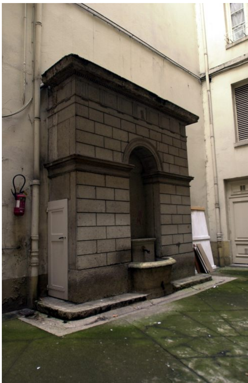
La fontaine monumentale : vue d'ensemble
