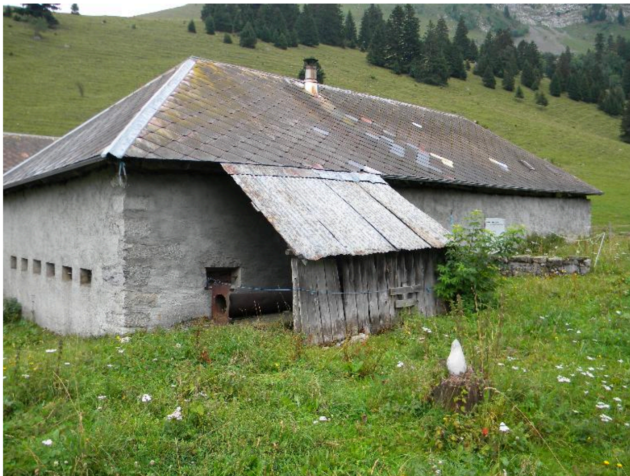
Vue de la façade arrière du bâtiment d'habitation.
