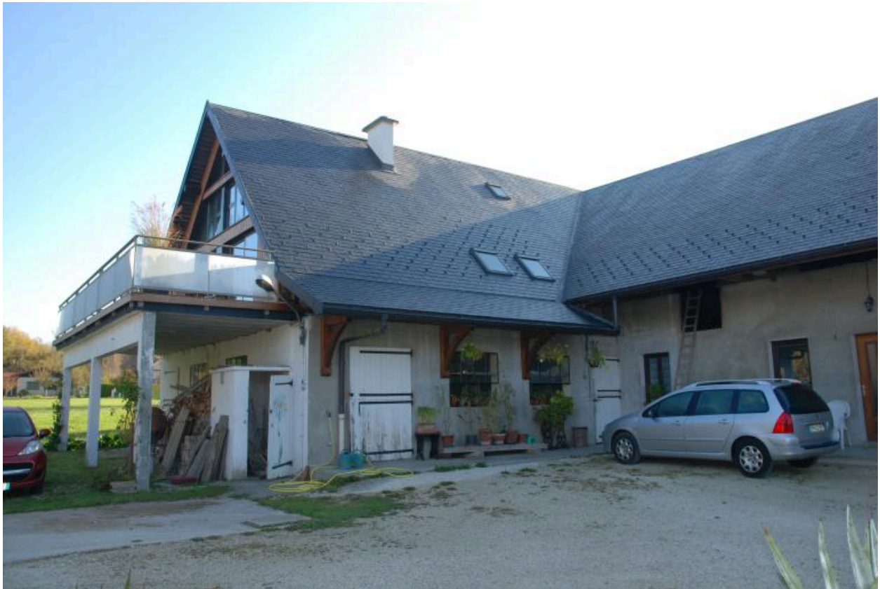
Vue d'ensemble du corps de bâtiment en retour d'équerre sur cour.
