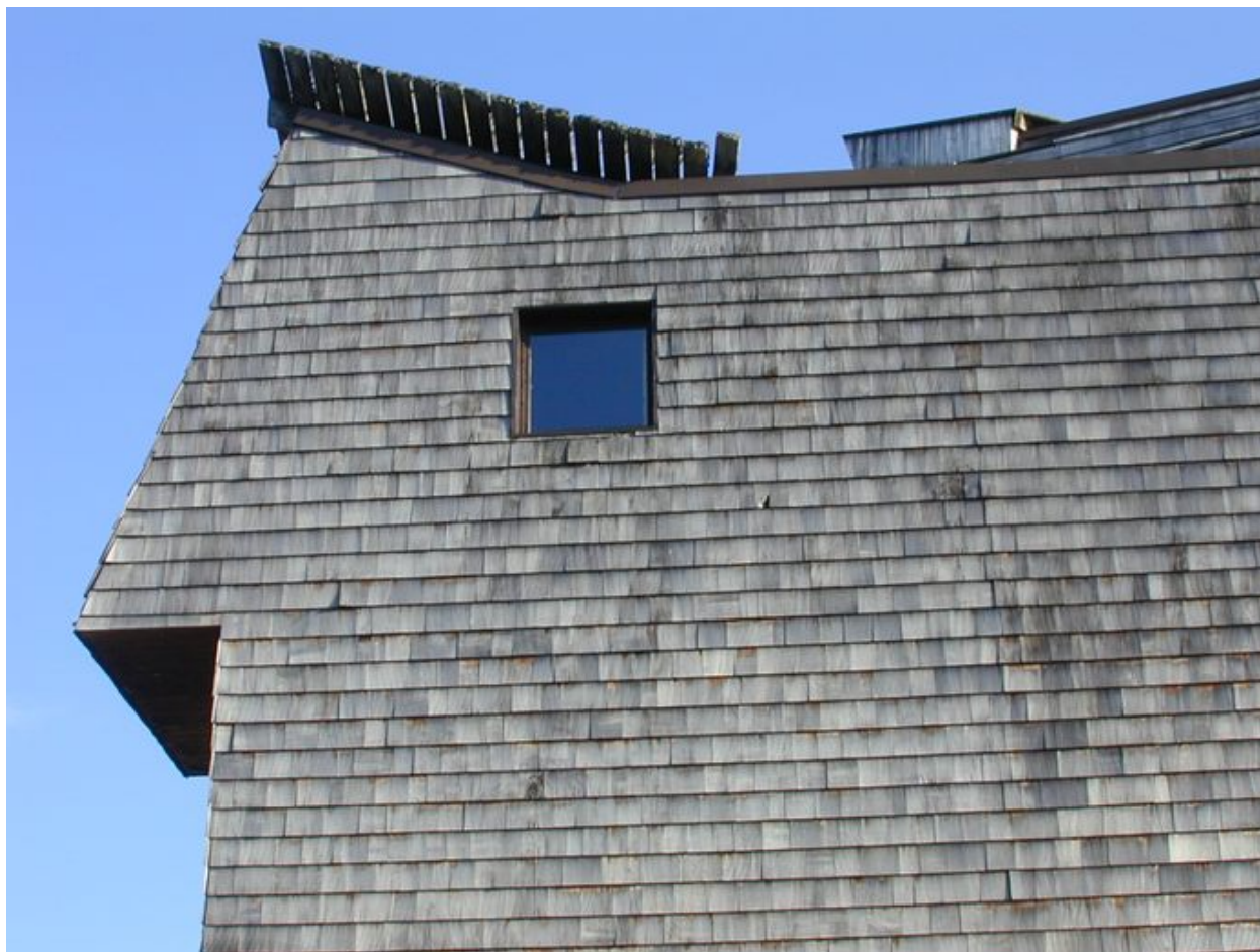
Détail du pignon nord
