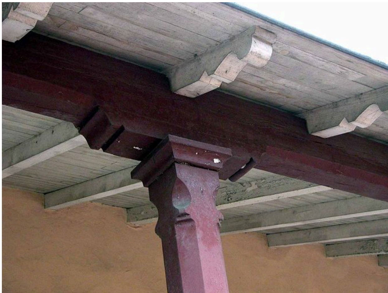
Cour nord-ouest, portique nord, détail du chapeau d'un pilier (avant travaux)
