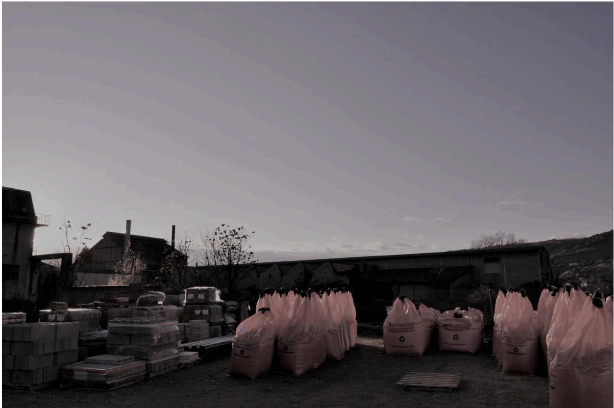
Vue du parking Est : série de sheds en béton armé.
