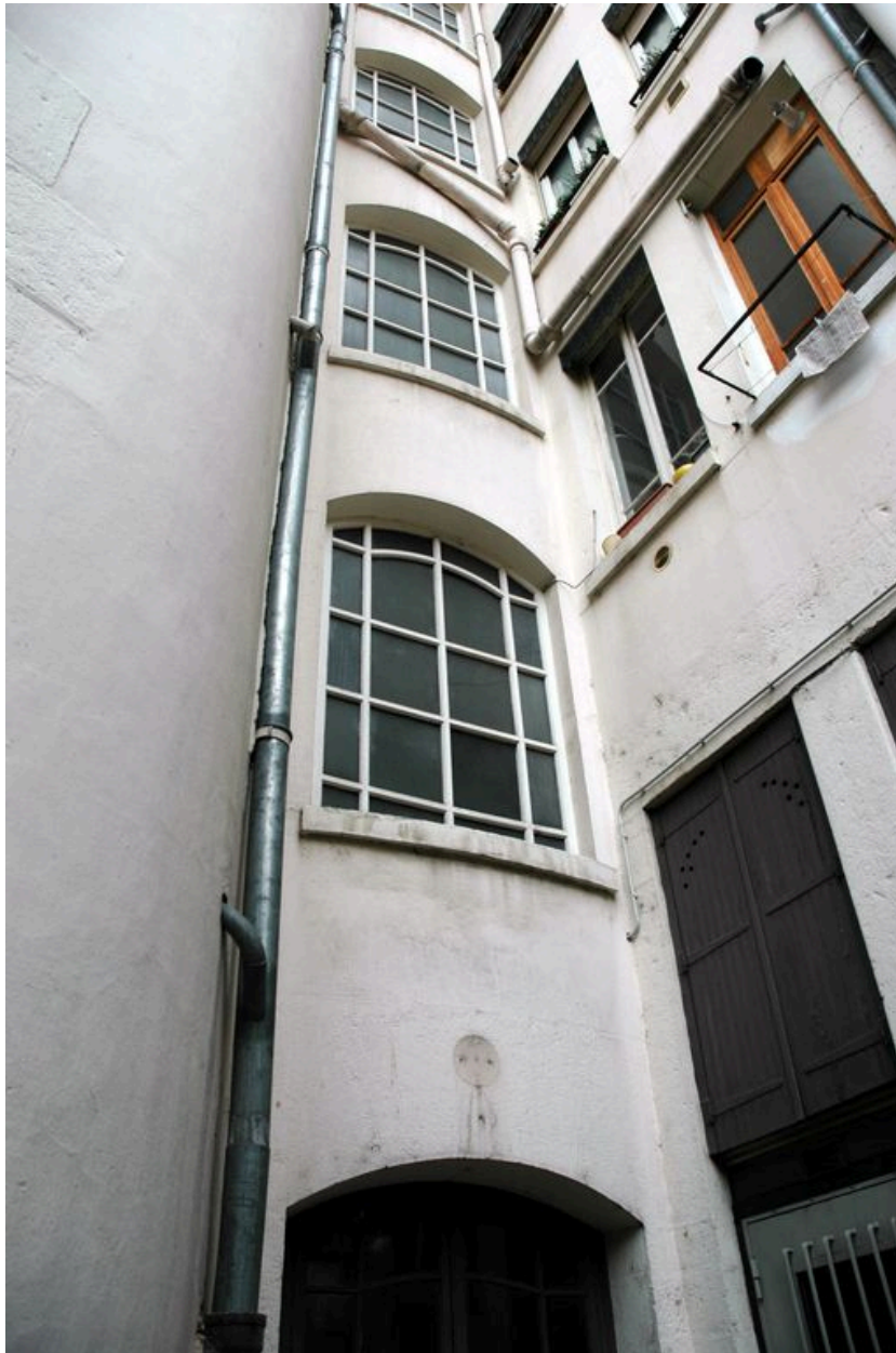
Vue de la cage d'escalier depuis la cour
