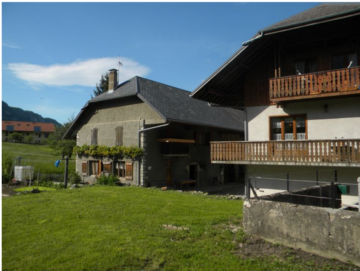
Vue d'un ensemble de ferme le long de la Bornette près du pont Eternel.
