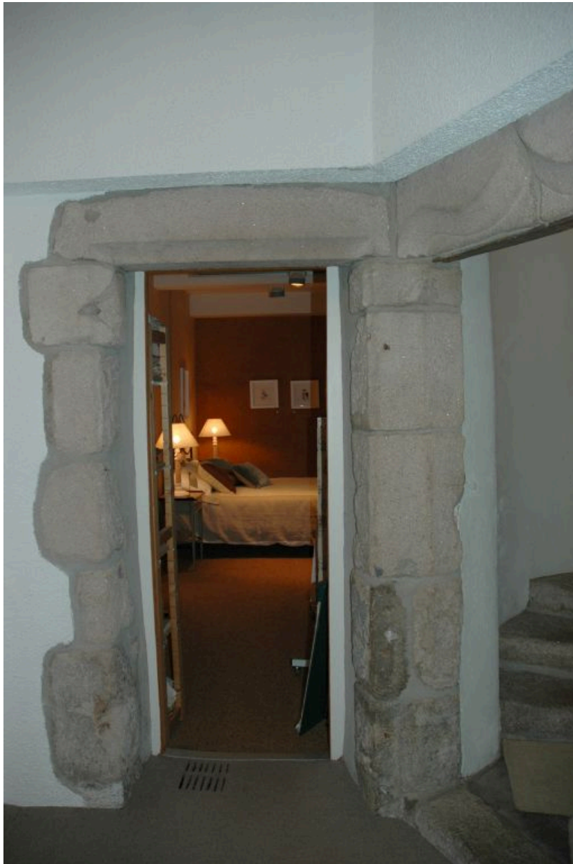
Encadrement de porte avec linteau à cavet.
