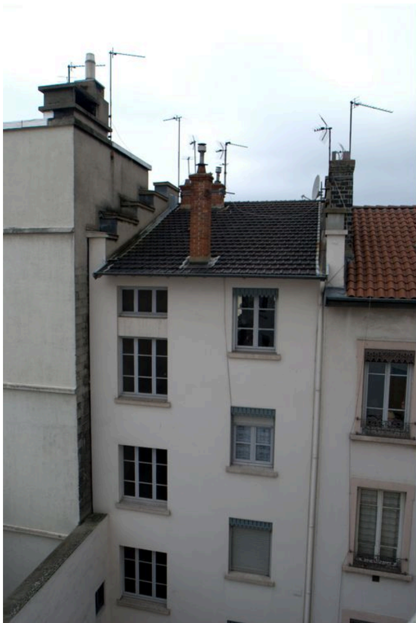
Elévation postérieure, vue partielle
