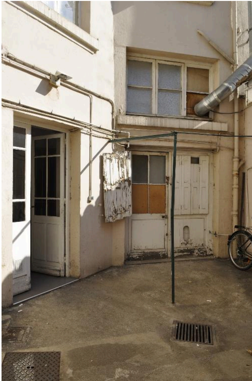
Cour : ancienne loge de concierge surmontée d'une chambre, sous l'escalier
