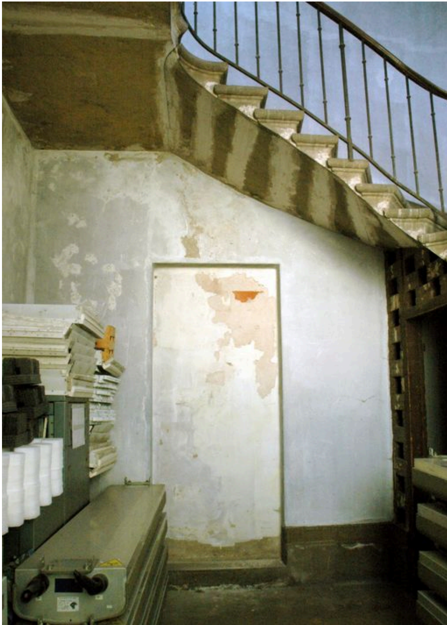
Bâtiment de la galerie, cage d'escalier, ancienne porte donnant accès au rez-de-chaussée du corps de bâtiment est, aujourd'hui murée
