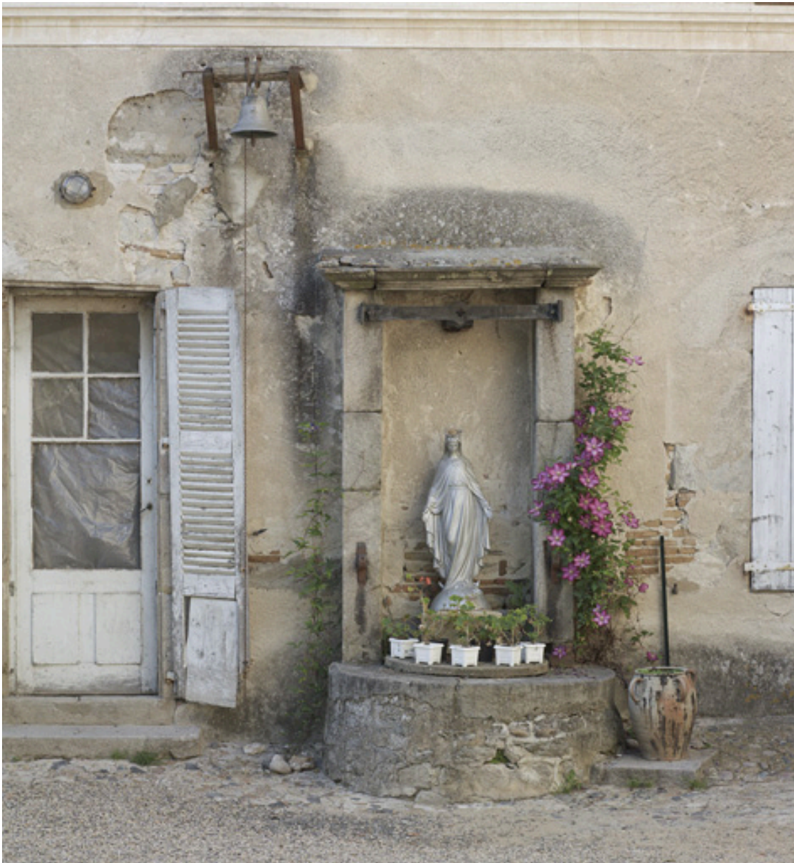
Vue du puits situé devant le logement du gardien.
