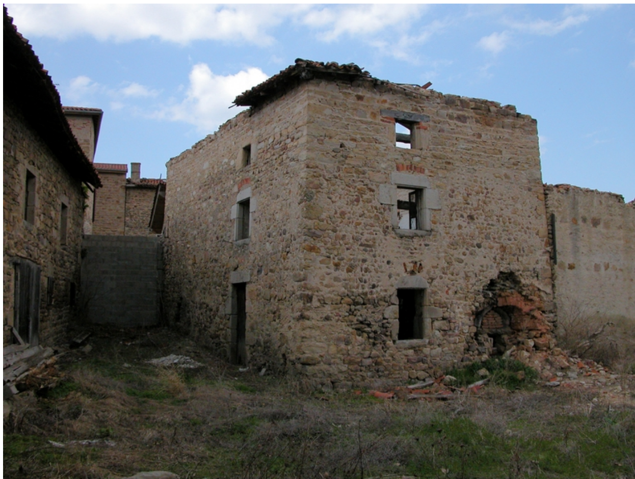
Vue d'ensemble du logis de la cour sud, depuis le sud-ouest.
