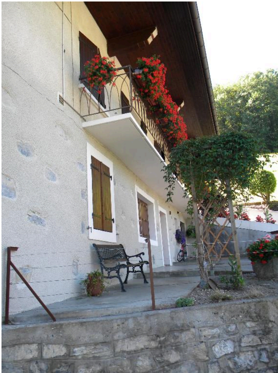
Vu de la façade principale d'une ferme remaniée (2008 D10 3537).
