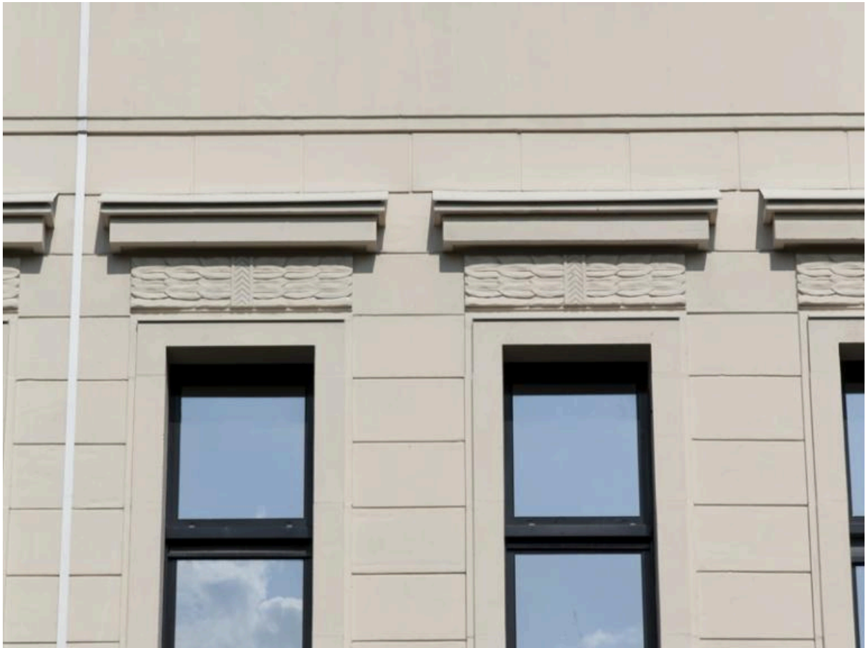
Hôtel-Dieu de Clermont-Ferrand. La faculté d'odontologie, détail des baies de la partie droite de la façade principale.
