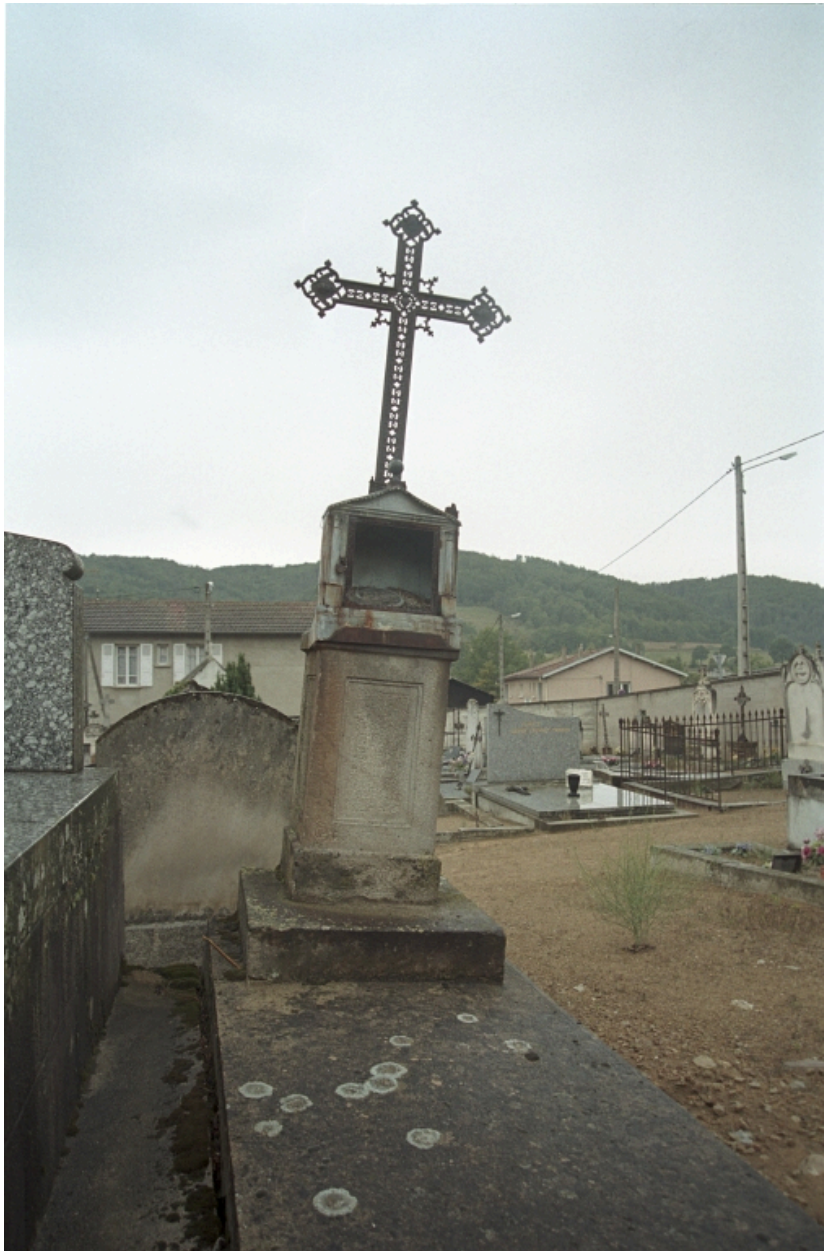
Vue d'ensemble d'une stèle avec une niche et surmontée d'une croix en fonte.
