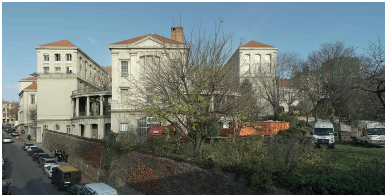
Vue de l'élévation sud.
