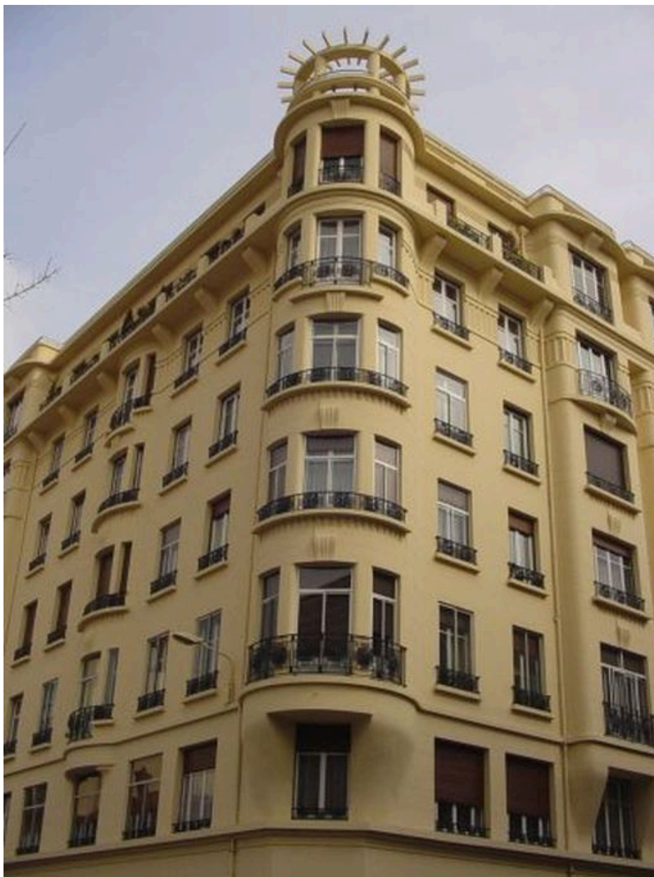
Vue générale de l'élévation (angle rue de la Tête-d'or, rue Montgolfier) depuis le sud-ouest
