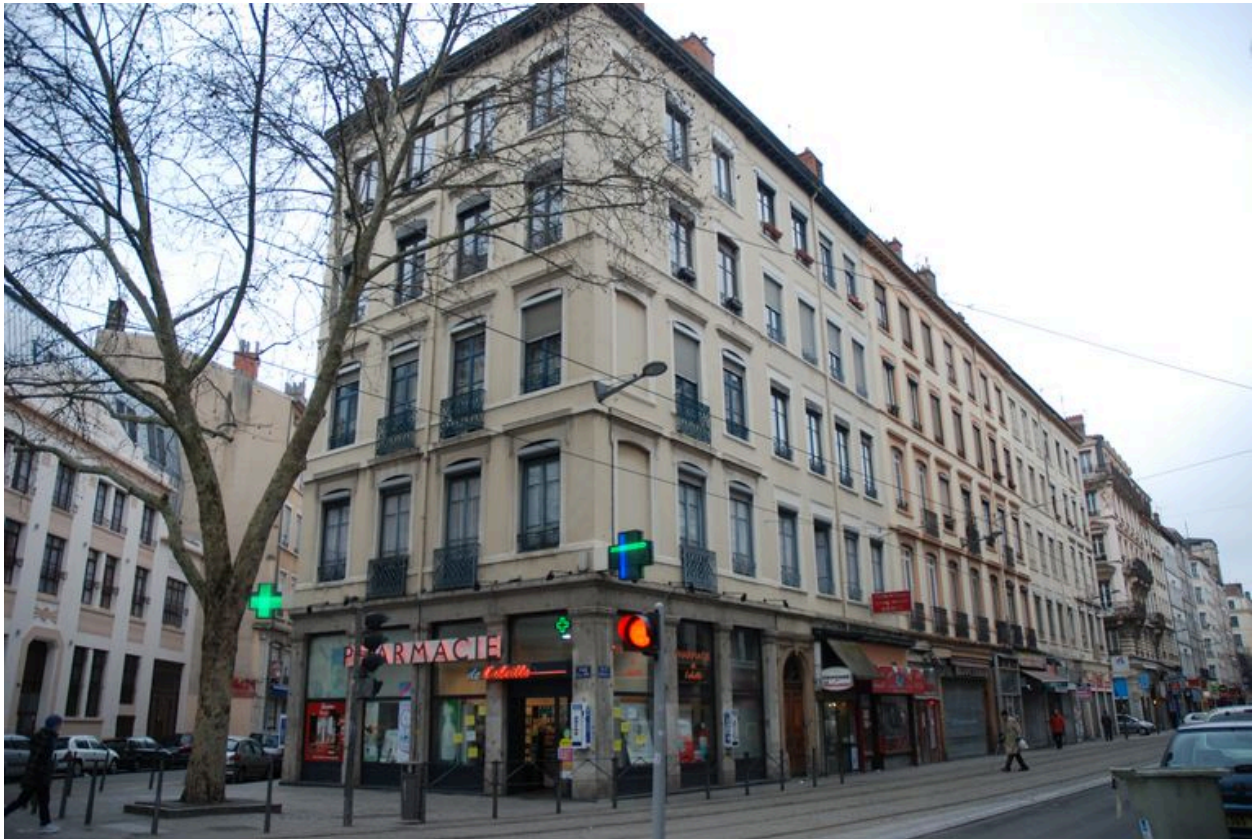
Vue générale nord-ouest, depuis la rue de Marseille
