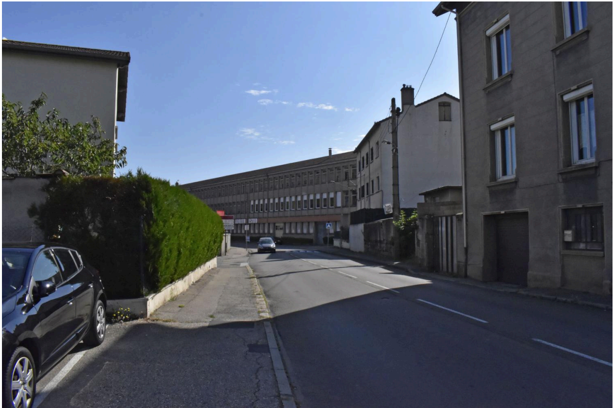
Vue du lycée en arrivant de l'ouest. [Photo chercheure.]
