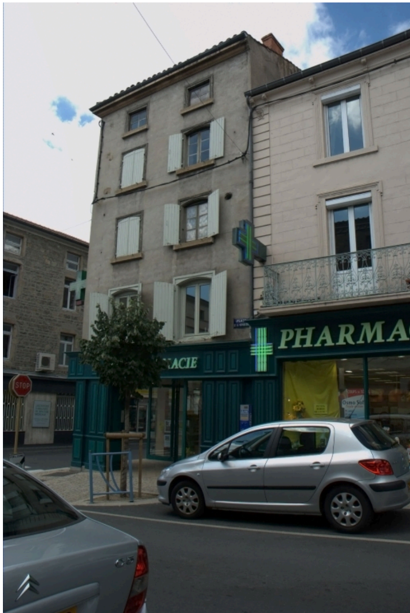
Îlot 4. République (place de la) 16. Vue générale de la façade sur la place.
