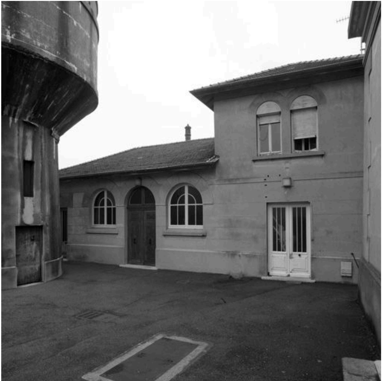
Bâtiment 9-10, façade ouest
