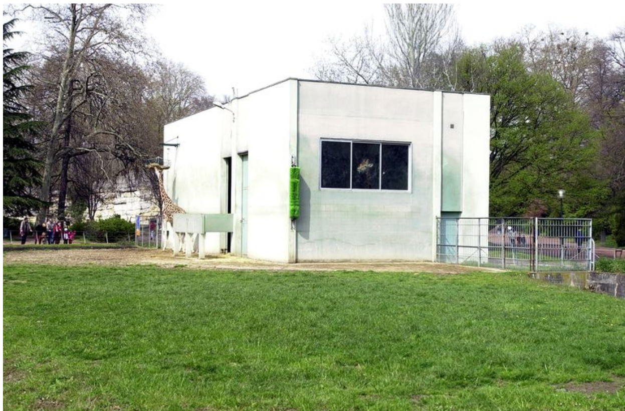
Le pavillon des girafes : élévation sud
