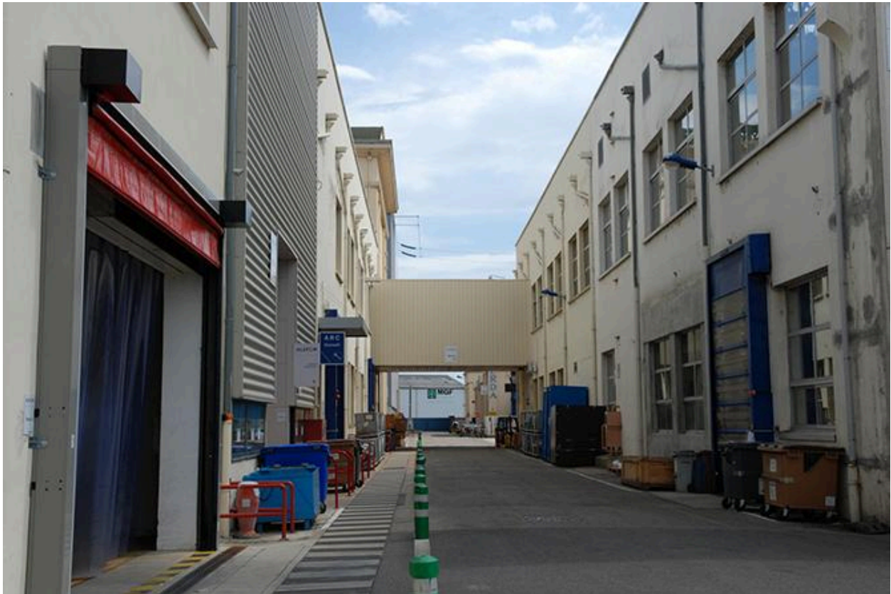
Vue des circulations extérieures du site
