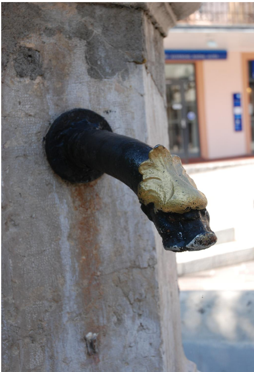
Fontaine, place Charles-Albert. Détail du tuyau.
