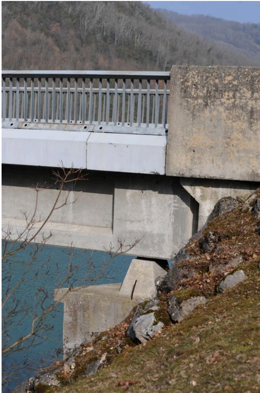
Culée gauche, face aval, vue de détail : jonction avec le tablier (depuis la rive gauche)
