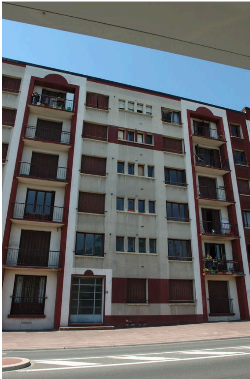
Détail de la façade sur rue.
