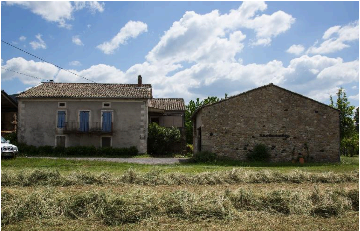
Maison et grange : façades est
