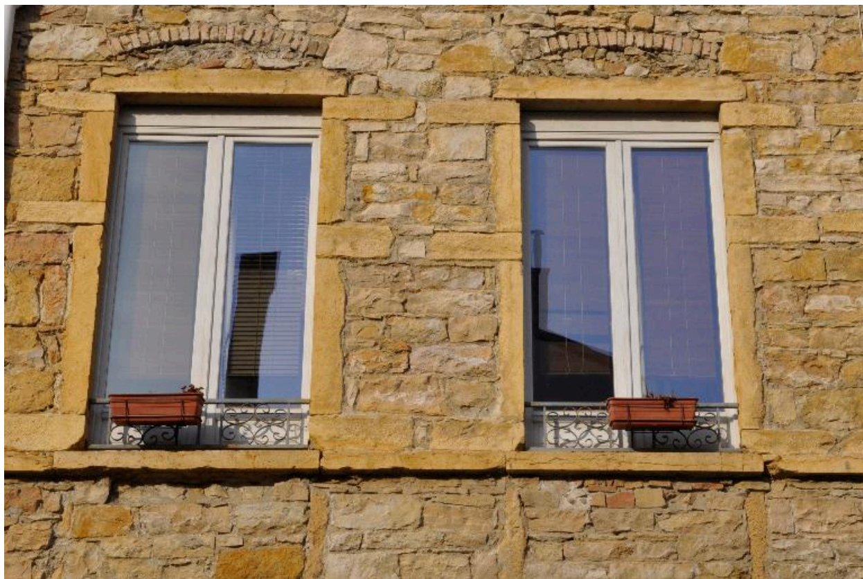
Immeuble sur rue, détail des fenêtres
