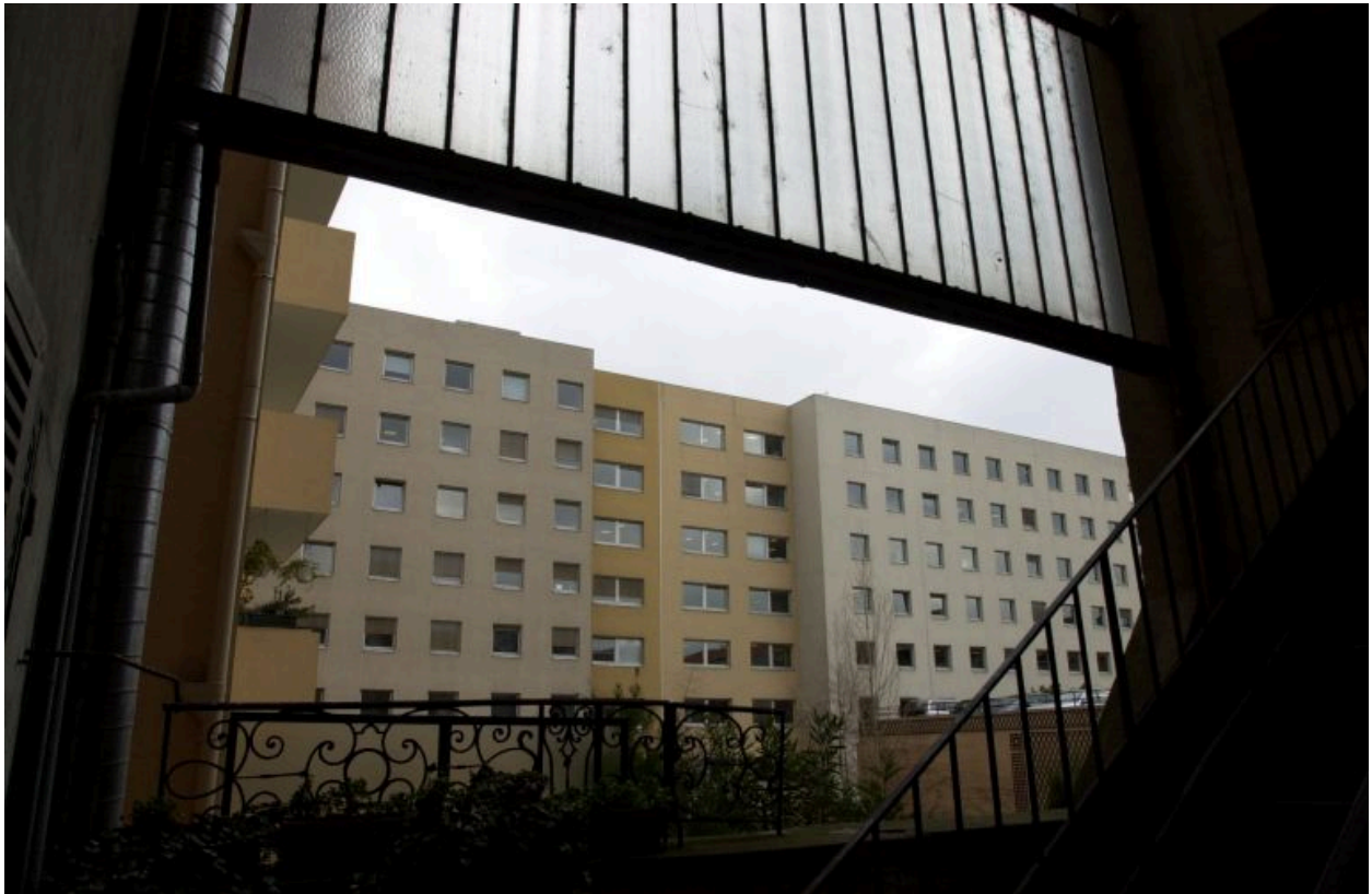
Elévation postérieure depuis l'escalier du 21 cours Charlemagne
