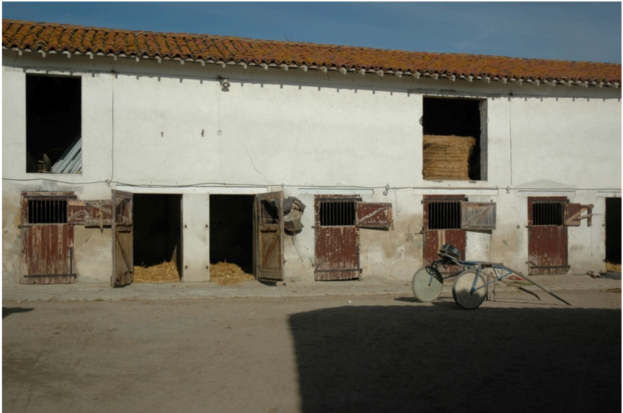
Vue de l'étable nord, depuis la cour.
