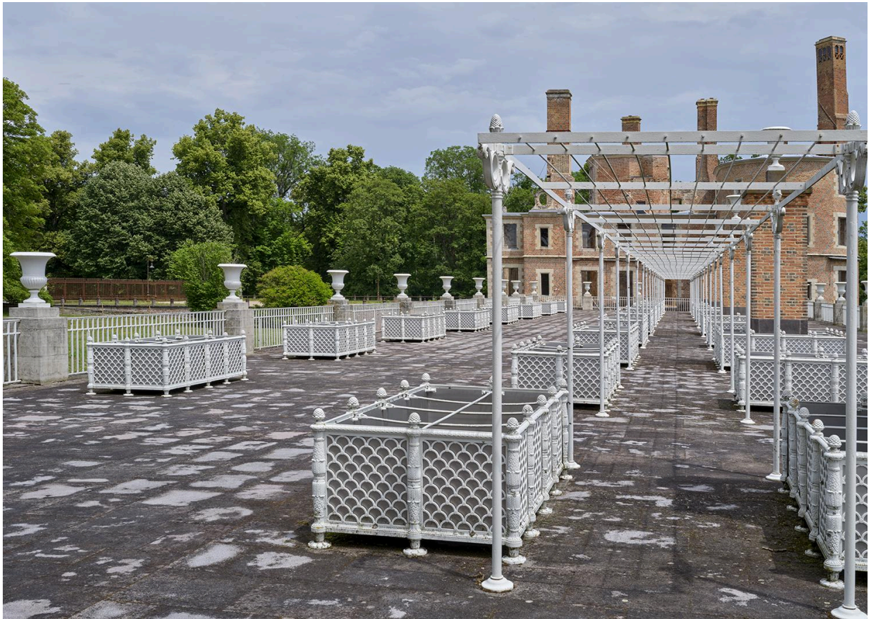
Vue de la pergola et des jardinières de la terrasse sur l'aile des cuisines
