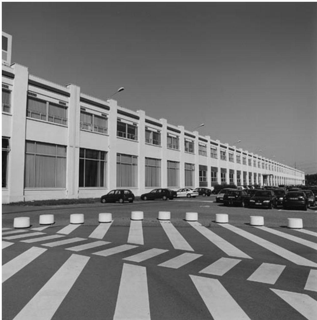
Vue d'ensemble des grands bureaux : hall 3, partie Achats
