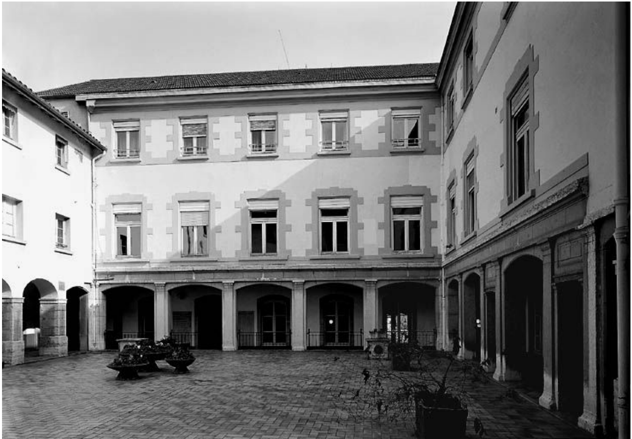
Cloître, vue d'ensemble de l'aile est
