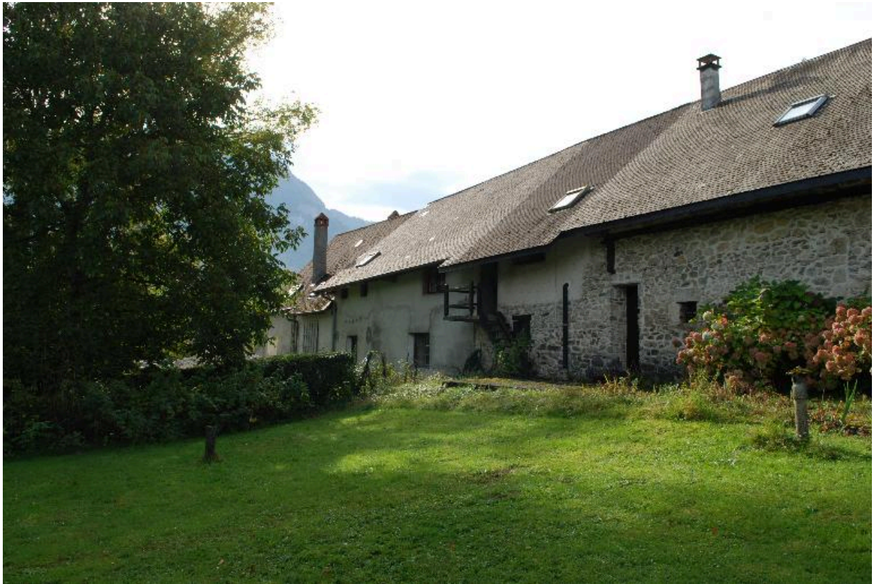
Vue d'ensemble d'une ferme à Verlioz (2014 B4 357), non repérée : façade arrière.
