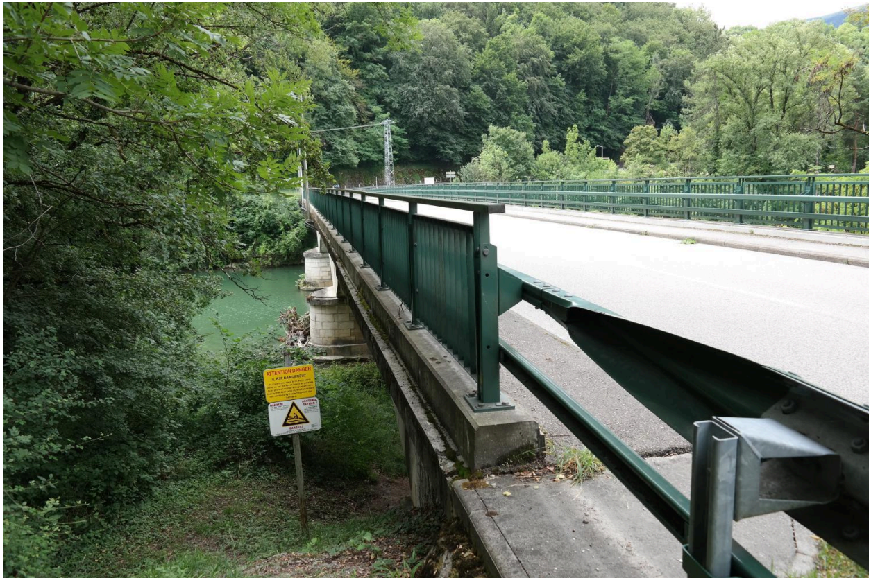
Pont du Fier. Détail des garde-corps
