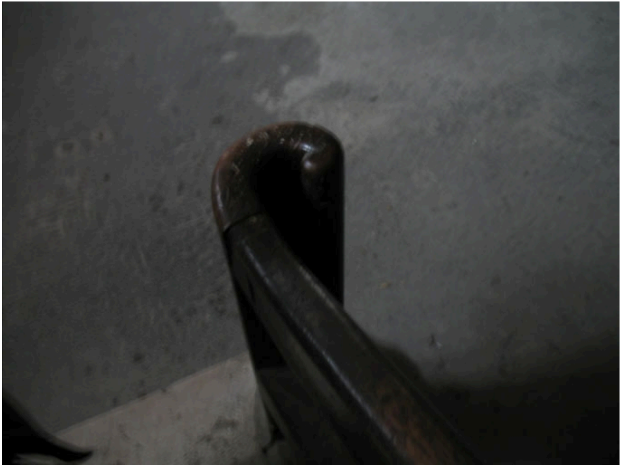
Rampe en bois : aile nord
