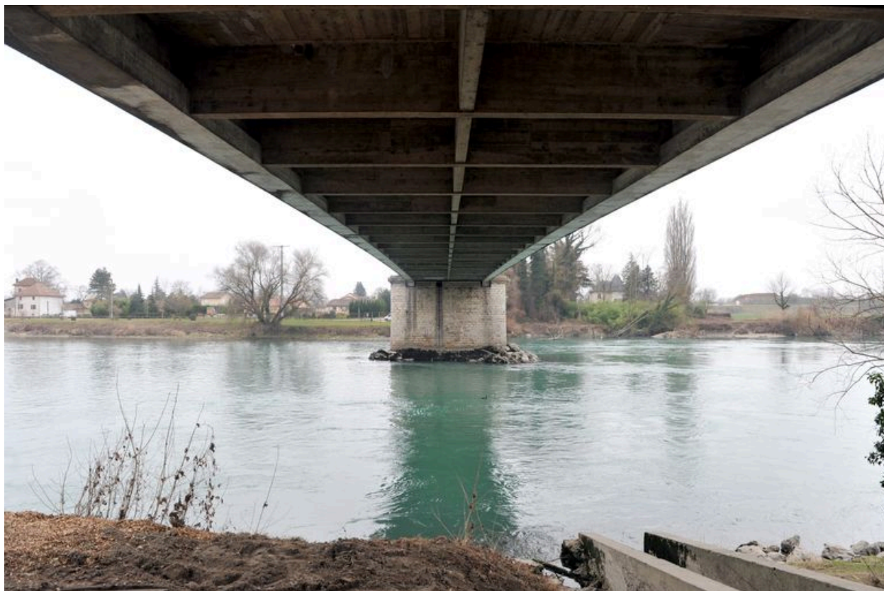
Vue générale, de dessous, tablier (depuis la rive droite)
